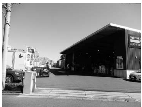
こちらは古紙ヤードの柏沼南営業所の入口外観
