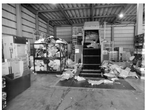
東京自動車機械製作所の大型ペーラーを設置
